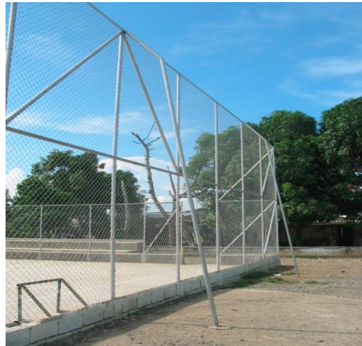
Imagen 4 Cerramiento en malla eslabonada. Altura detrás de los arcos
