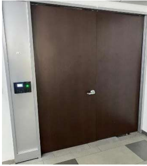
Ilustración 2. Acceso Data center
