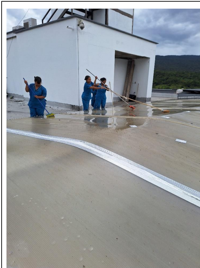
Limpieza y Desinfección profunda de estructuras cubierta.
