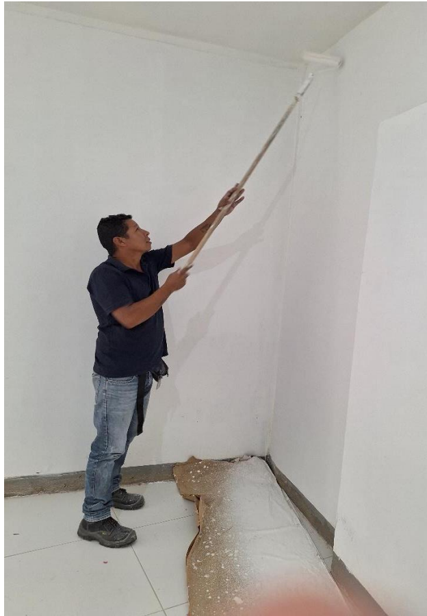
Mantenimiento, estucado, lijado y pintado edificio castillo real.
